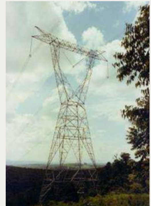
TL 765 kV – Foz de Iguaçu – Tijuco Preto
