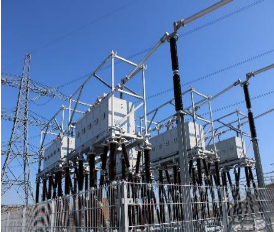
Figura 17. D-FACTS instalados en líneas de transmisión.
