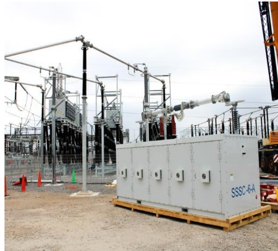
Figura 19. Beneficios por la rapidez en la instalación de las SmartValve en comparación con otras alternativas convencionales
